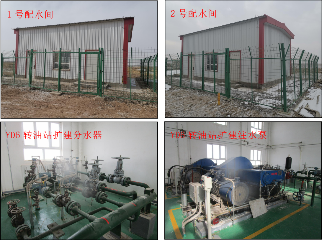
图2.3-6 站场现场情况
