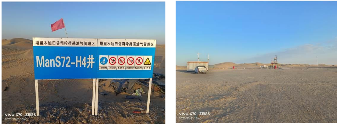
图 2.3-3 井场现场情况
