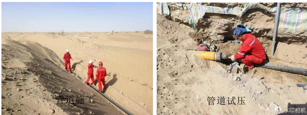
图 2.3-6 集输管线施工情况
