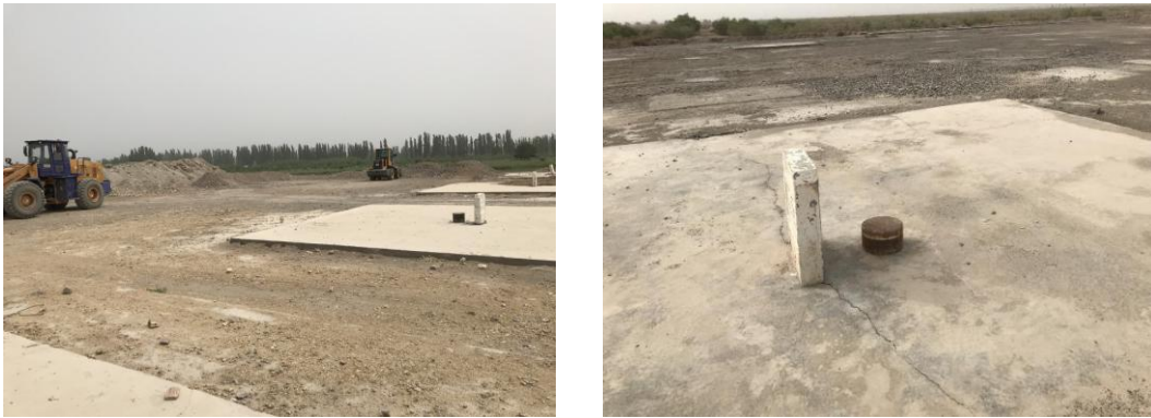
图 3.1-4 哈拉哈塘油田区域长停井封井效果
