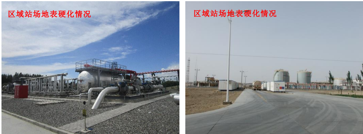
图 3.1-2 区域井站场周边恢复情况及占地现状
