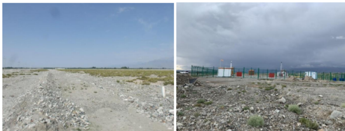
图 3.1-1 井场及周边植被恢复情况图
