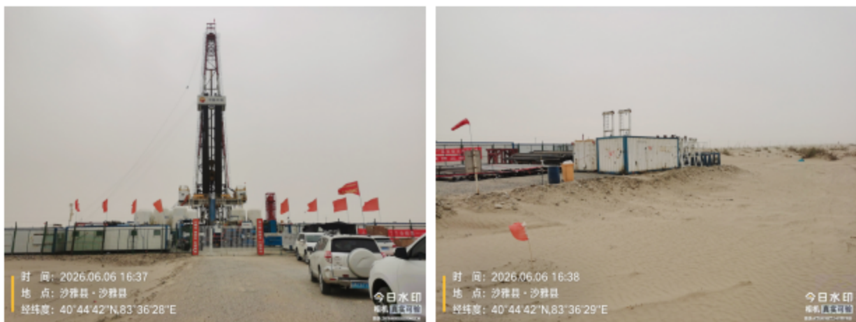
图 3.2-1 井场现状现场照片
