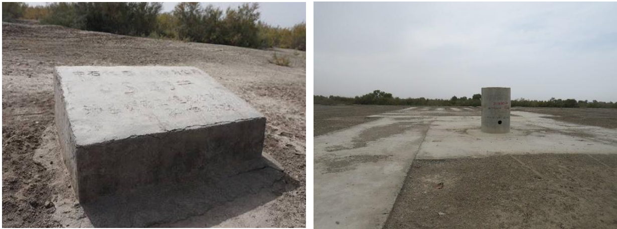
图 3.1-4 塔河油田区域长停井封井效果
